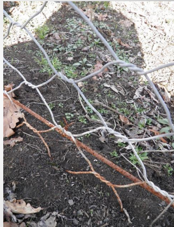
detalj heksagonalnog žičanog pletiva sa armaturom ("6")
